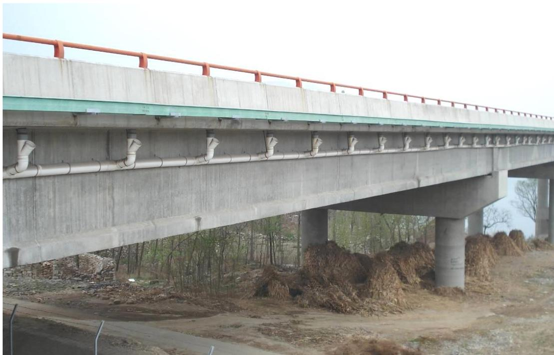
图 7.5-2 径流收集系统实景照片
