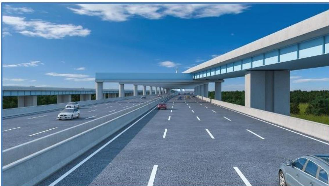
图10.1-6 分离线小角度上跨主线设置框架式隐形桥墩效果图
