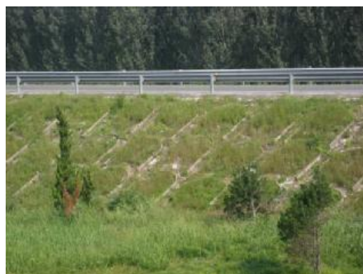
图 2.3-2 (2) 拱形骨架防护
