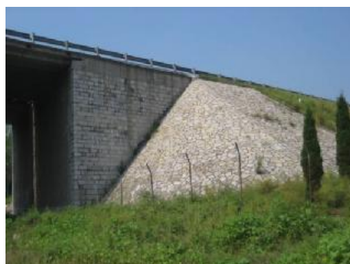
图 2.3-2 (4) 桥头浆砌片石防护
