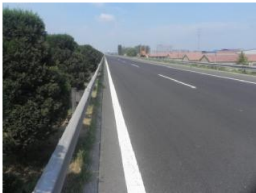
图 2.3-4（1）凸式中央分隔带
